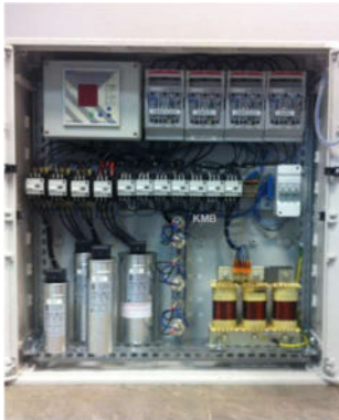
Widok i układ połączeń kompensatora hybrydowego z członem TCR
