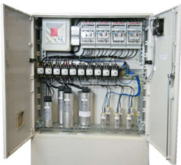
Widok i układ połączeń asymetrycznej baterii kondensatorów
