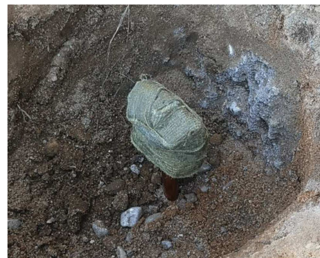
▪ szczelne zabezpieczenie antykorozyjne połączenia skręcanego
