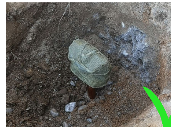
▪ prawidłowe zabezpieczenie taśmą typu DENSO
