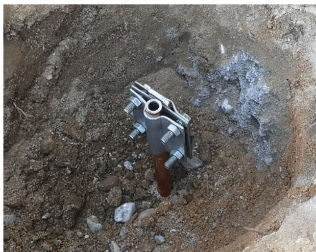
▪ uchwyt krzyżowy: połączenie uziomu poziomego z uziemem pionowym
